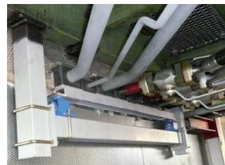
Montage de potence d'appui
