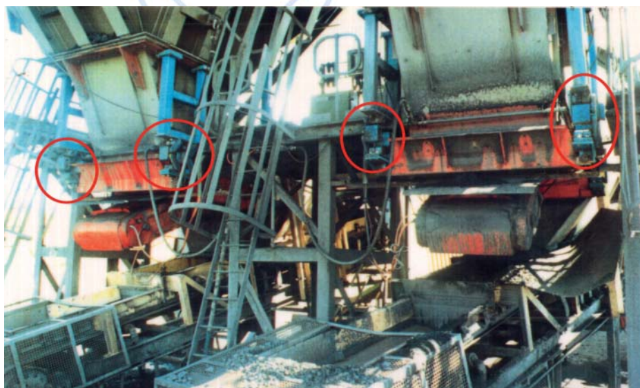
Canaux de décharge pour des silos de charbon à New South Wales, suspendus par des éléments AB 50
