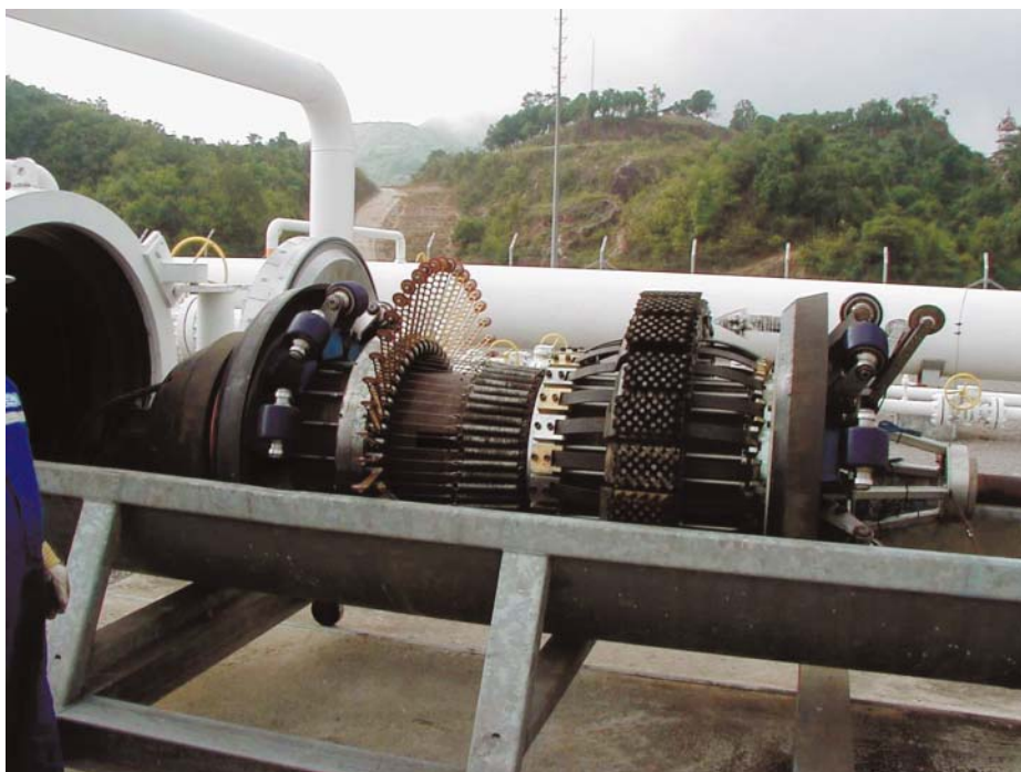
Installation de la „taupe“
