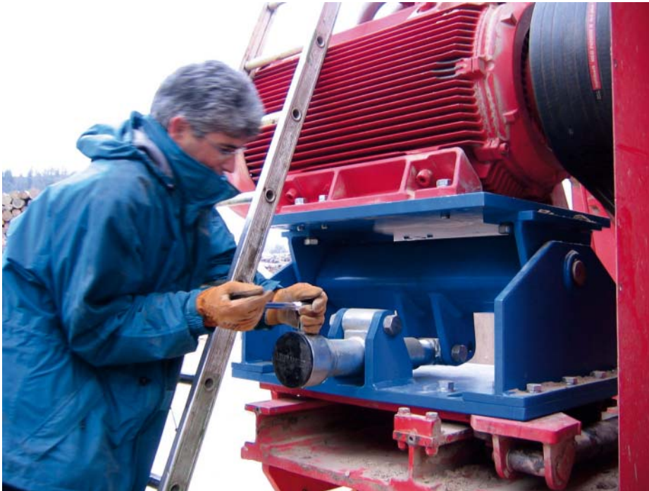
Tensionnement des courroies au moyen d'un vérin de levage
