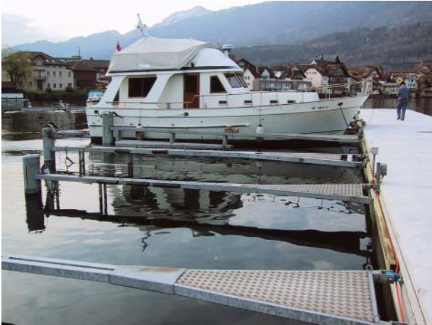
Installation de port avec barres flottantes
