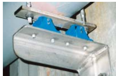
Logement de compensation élastique de tubes pour vapeur surchauffée sur éléments amortisseurs type V-38.
