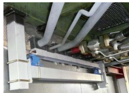
Montaggio di un giogo di sostegno
