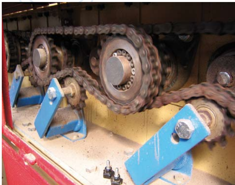
Installazione di elementi tenditori elastici in una sezione di alimentazione
