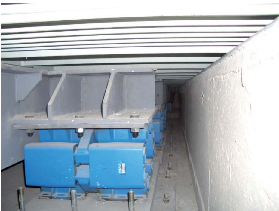
Pavimento flottante appoggiato su AB 50-2 TWIN
