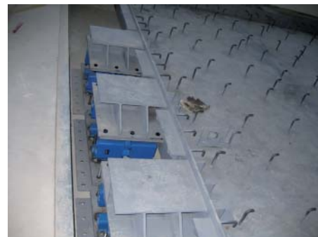
Basamento: 6 x 9 m del peso di 36 T supportato da n. 28 AB 50-2 TWIN
