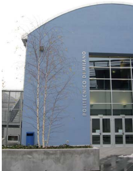
Dipartimento di Meccanica del Politecnico di Milano
